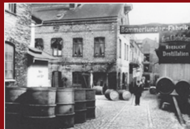
Den gamle fabrik på adressen Holm 39 i Flensborg.
